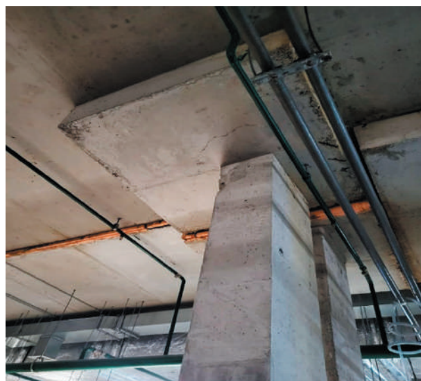
Рис. 2. Фото деформационного шва (слева) и трещины в капители (справа). Фото: А.М. Макарова
