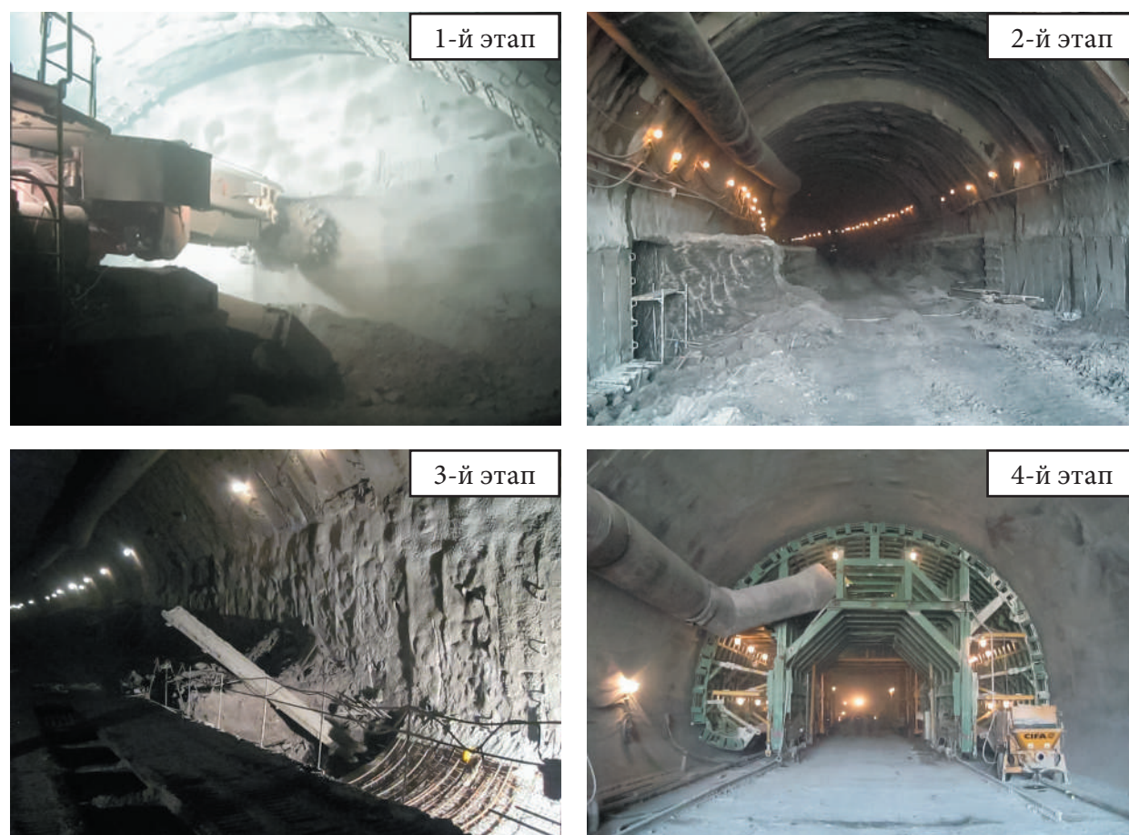
Рис. 6. Основные этапы строительства автодорожных тоннелей № 5/5а дублера Курортного проспекта в Сочи. Фото: Е. А. Ермолина
