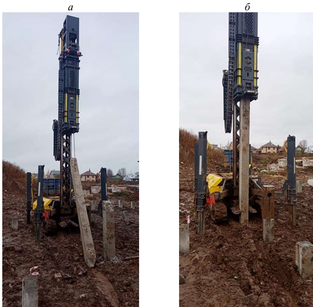
Рис. 12. Опытная забивка свай, армированных СПА, на строительной площадке (фотографии предоставлены автором)
